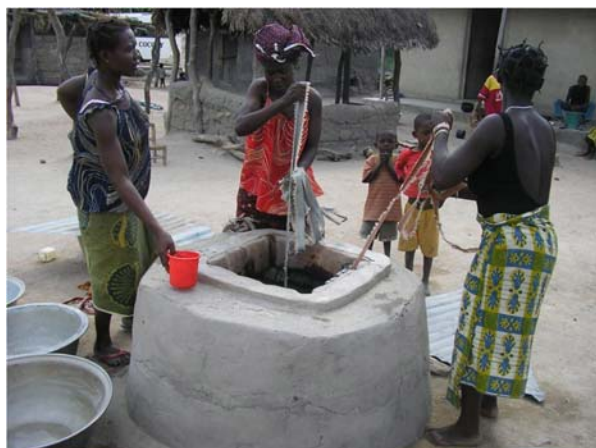
Exemple de puits traditionnels creusé manuellement dans les latérites du socle altéré à Bondoukou (Centre-Est, Zone 2)
