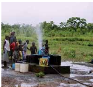
Redéveloppement au compresseur
