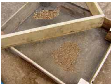
Le calibrage du massif filtrant
