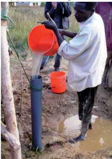
Rinçage du forage à l'eau
