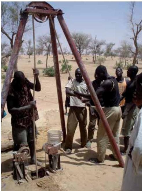
Outil de battage manuel au trépan
